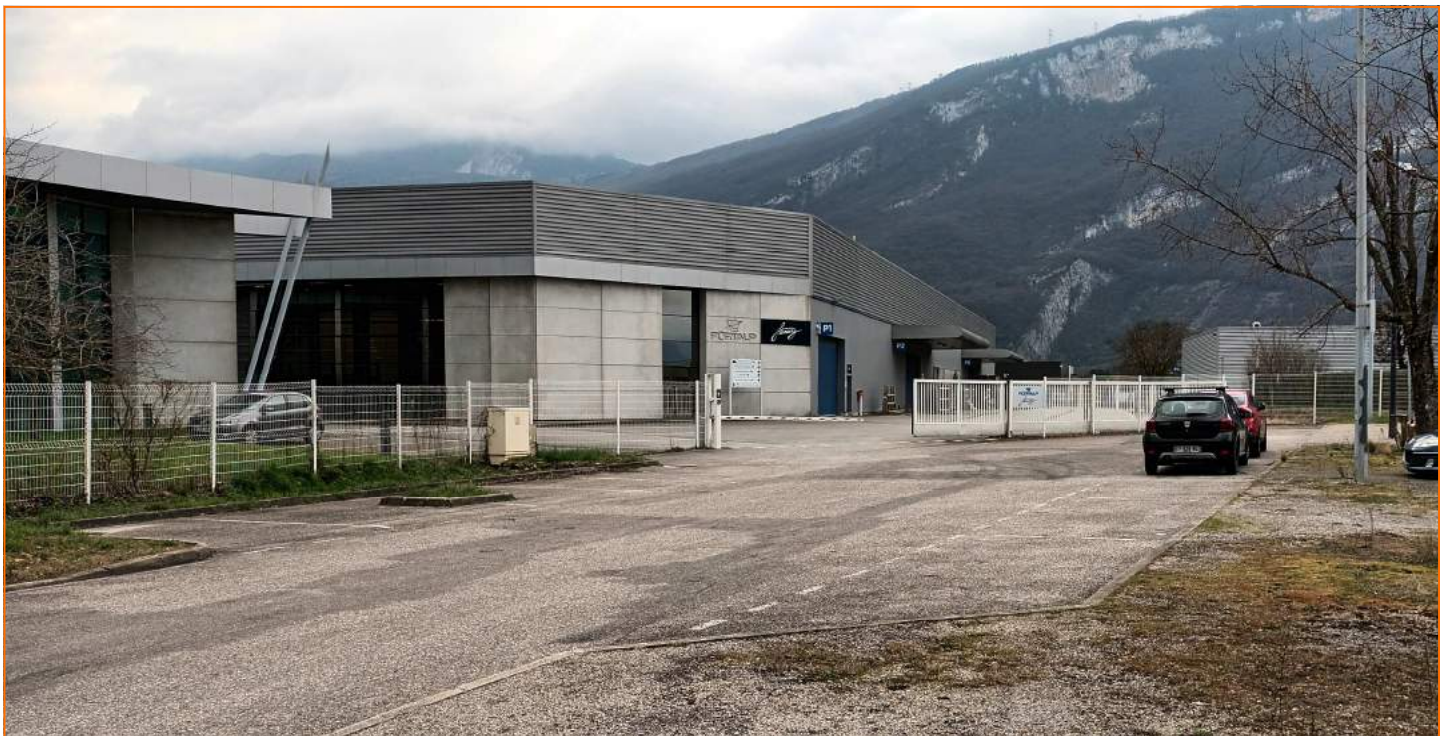
Entrée principale et bâtiment entrepôt
