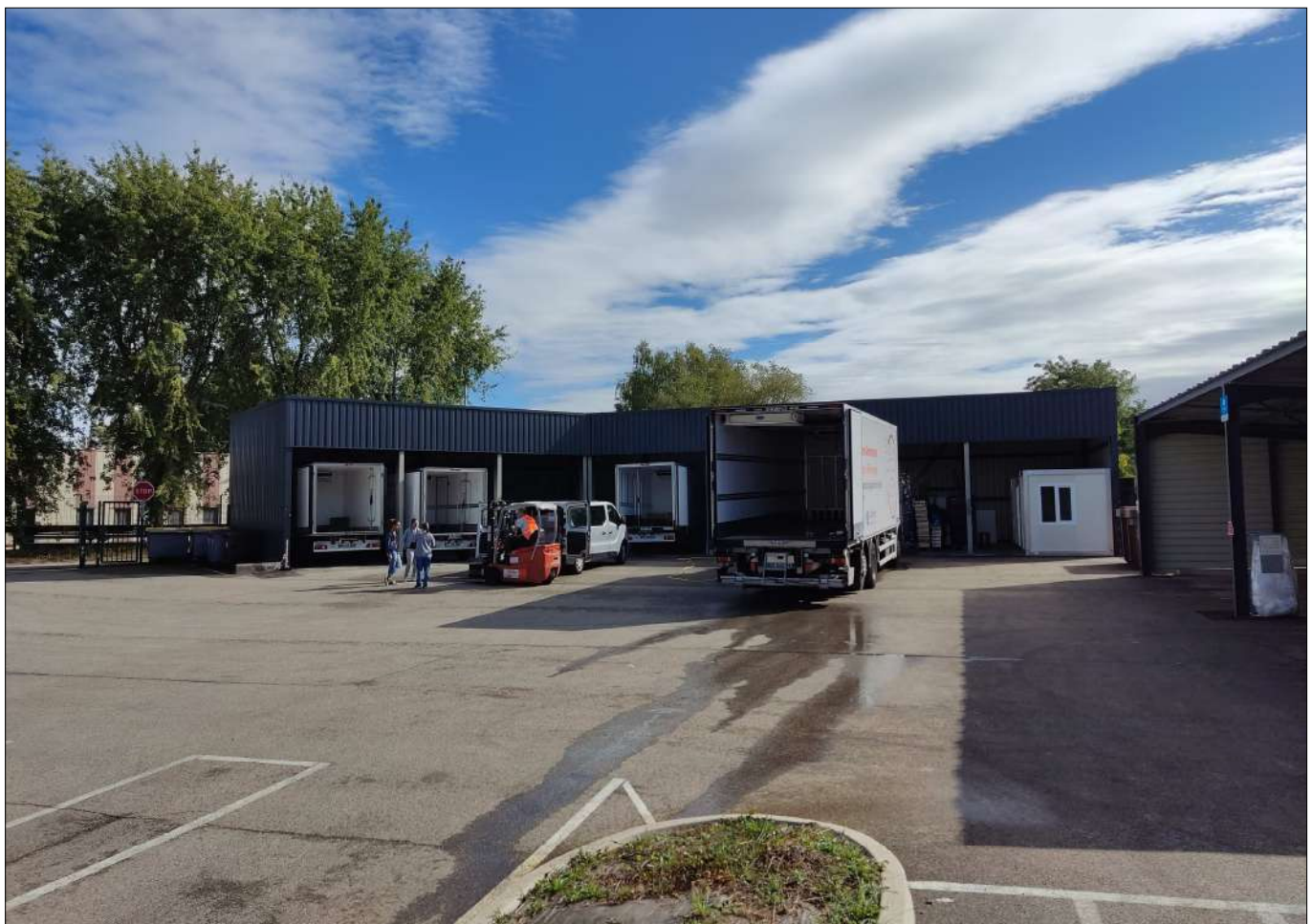
Des espaces extérieurs permettent la circulation, le stationnement et les manœuvres des véhicules (Banque Alimentaire de l'Ain)
