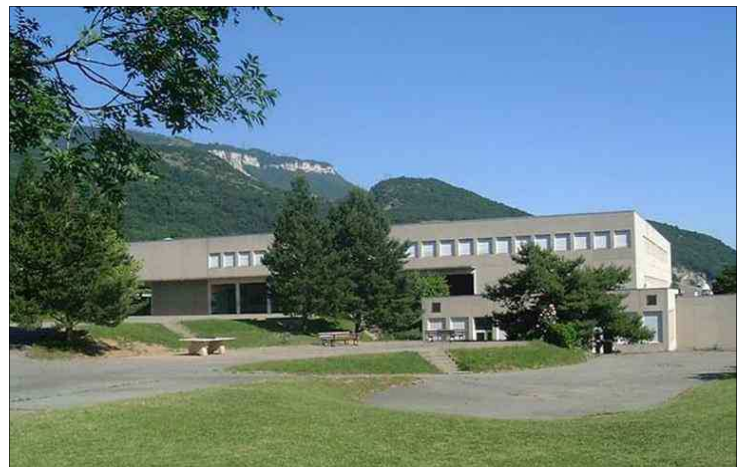
Vue d'ensemble du collège Marc Sangnier de Seyssins
